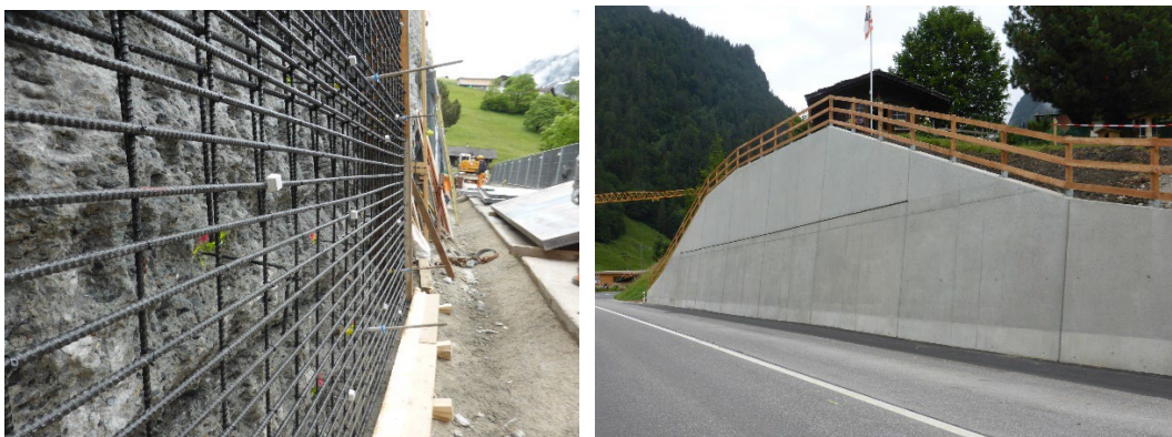
Abb. 3.9 Links: Basaltfaser-Bewehrungsnetze eingebaut. Rechts: fertige Stützmauer. Fotos von Basalt Fibertec GmbH.
