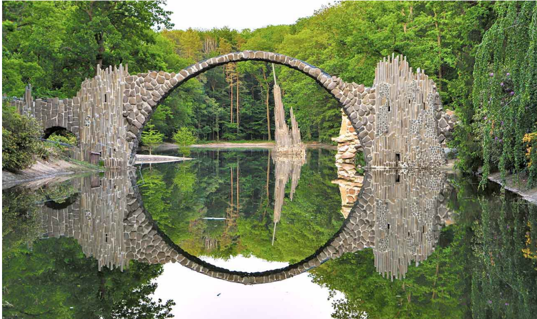
Abb. 3.2 Rakotzbrücke in Kromlau Deutschland gebaut aus Feld- und Basaltsteinen. Foto: Jörg Krause [80].
