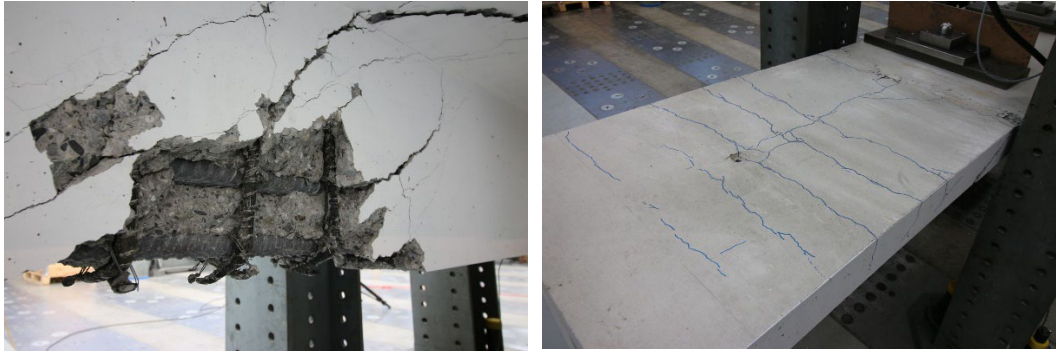
Abb. 7.68 Träger 2 nach dem Bruch. Links: Detailansicht der offenen Bügel. Rechts: angezeichnete Risse an der Trägeroberseite.
